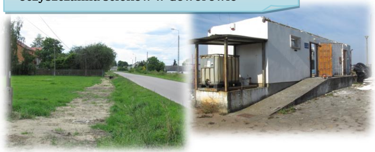
Kanalizacja m. Wólka Brzezińska i oczyszczalnia ścieków w Goworowie
