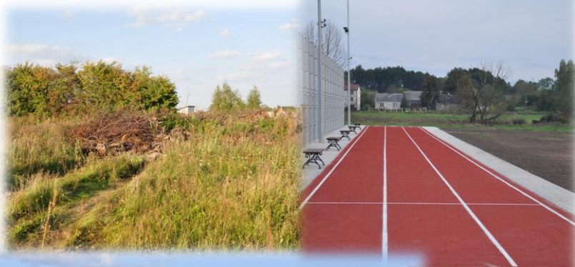
Budowa kompleksu boisk ORLIK 2012
