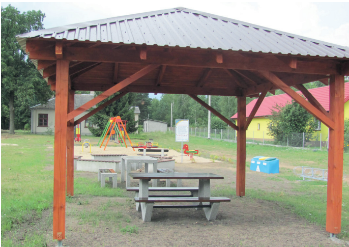
Miejsce rekreacji w Kaczcze (fot. arch. UG w Goworowie)
