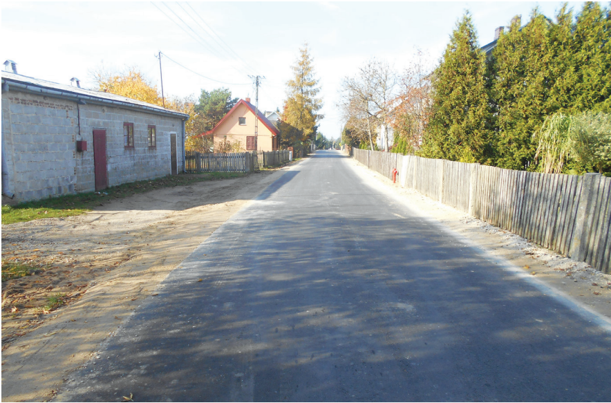
Remont drogi w Ponikwi Małej (fot. arch. UG Goworowo)
