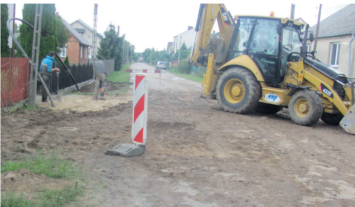
Budowa kanalizacji Daniłowo (fot. arch. UG Goworowo)
