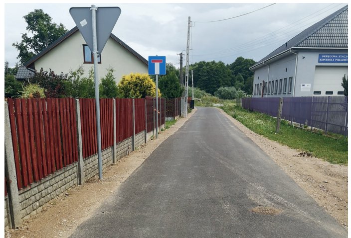
Nowa droga w Wólce Brzezińskiej (fot. arch. UG Goworowo)
