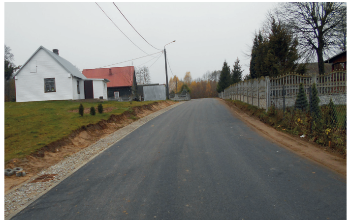
Nowo wybudowana droga w m. Góry (fot. arch. UG Goworowo)
